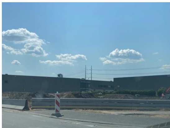
Pand Technische Unie in aanbouw
